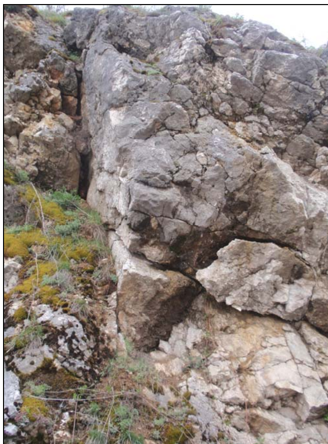
Slika 4. Karakteristična pukotina u području kružnog raskrižja
