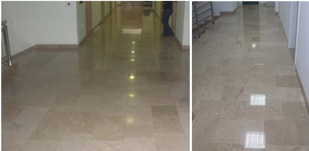
Slike 6.-7. Kamene ploče dimenzija 30xNx3 cm od poliranog kamena „osoje“ u zgradi Općine Posušje (lijevo), te u poslovnoj zgradi „IGH“ Mostar (desno). Kamen je ugrađen bez reški
