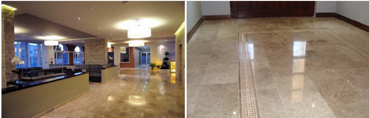
Slike 10.-11. Detalji podnih obloga od kamena „rujan“ u podovima Hotela „Međugorje & Spa“, Međugorje (lijevo) i Hotela „Quercus“, Međugorje (desno)
