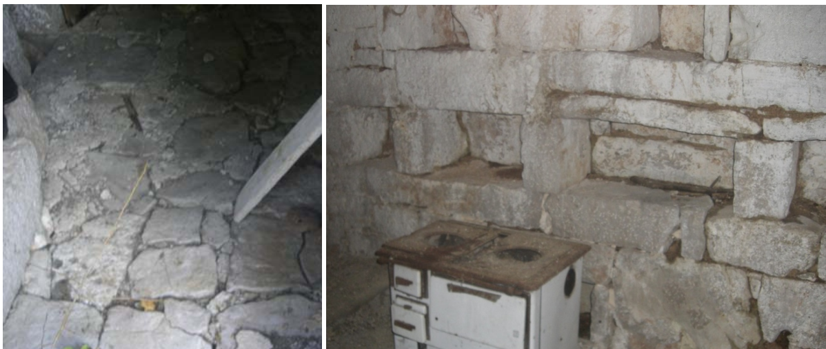
Slike 4.-5. Kameni pod planinske kuće pored Rakitna, Općina Posušje, od lokalno raspoložive prirodne ploče. Ploče su debljine 5 do 10 cm, prirodne veličine (lijevo); Pravokutne niše u zidovima, veličine od 30x30 do 50x60 cm, lijepo obrađene u kamenu, koje su koristile za svakodnevno odlaganje pribora, posuđa, alata i raznih predmeta na istočnom i sjevernom zidu (desno)
