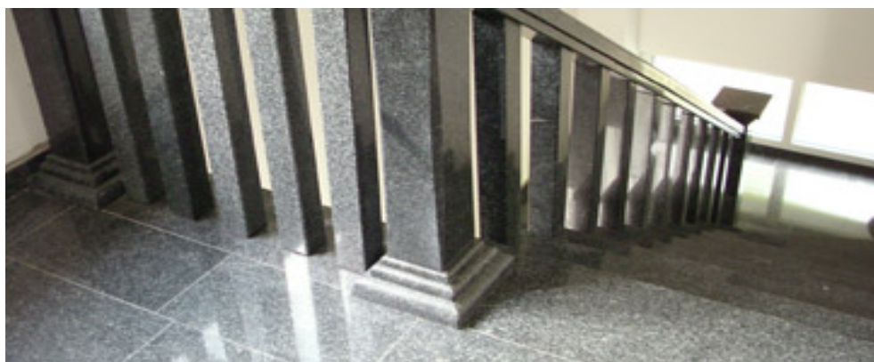
Slika 23. Stubište od kamena „gabro“, Jablanica
