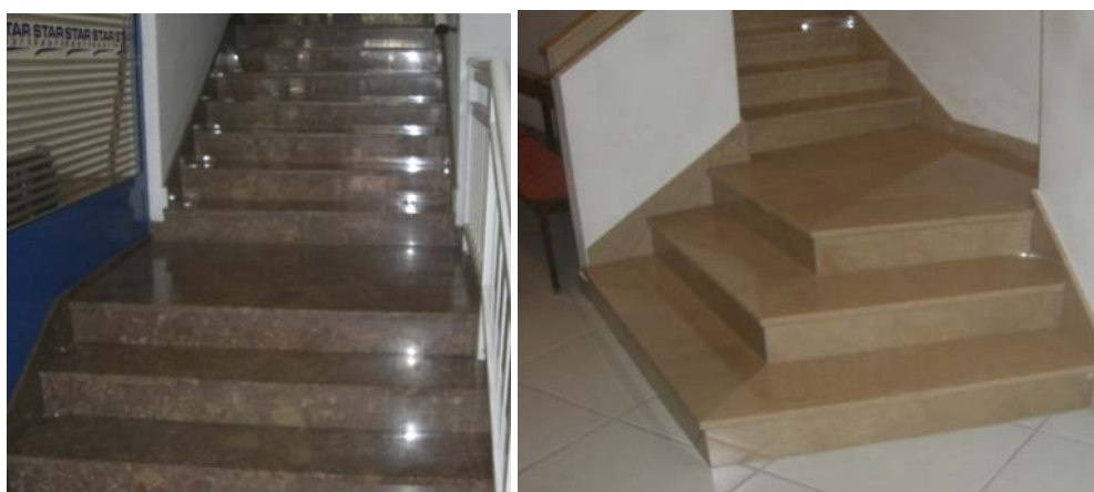
Slike 21.-22. Stubište u objektu na Pecari u Širokom Brijegu. Ugrađeni kamen je brečasti vapnenac, autohtoni kamen s lokaliteta Ljubotići, Općina Š. Brijeg (lijevo); Stubište u župnoj crkvi Posušje kamen tipa „Osoje“. Kamen je dolomitizirani vapnenac vađen na lokalitetu Gradac kod Posušja (desno)
