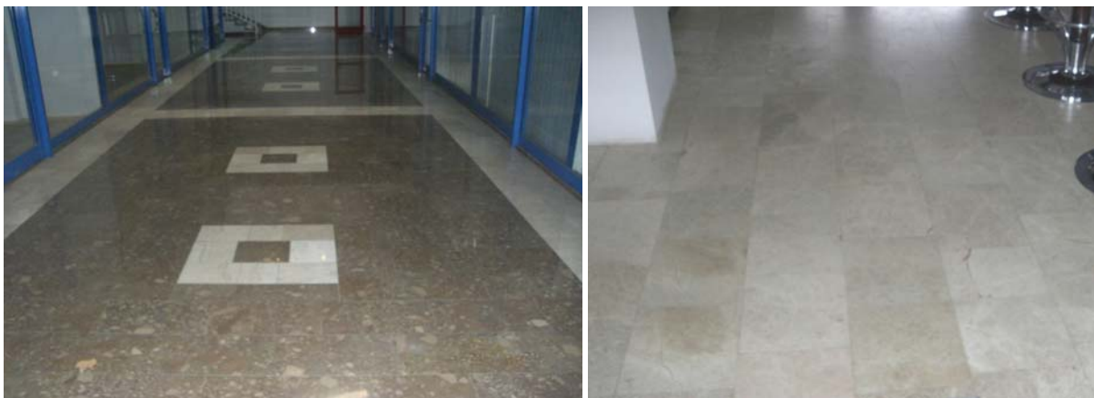
Slike 12.-13. Kameni pod na hodnicima i podestima u poslovnom objektu na Pecari u Š. Brijegu. Kredne je starosti i smeđe boje, vađen na lokalitetu Ljubotići. Kamen posjeduje vrlo dobre tehničke karakteristike, te u potpunosti zadovoljava sve uvjete za ugradbu u podove (lijevo); Kamen u podu ugostiteljskog objekta „Čabor“ u Posušju (desno). Dolomitizirani vapnenac nije vrhunske kvalitete, ali odabirom može udovoljavati na površinama manjeg prometa. Ploče dimenzija 30xNx3 cm, ugrađene prije 20 godina. Nema primjetnih oštećenja
