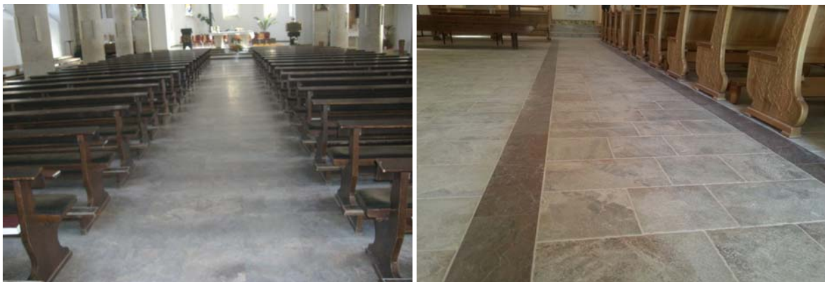
Slike 8.-9- Kamene podne ploče dimenzija 30x50x2 cm u crkvi Uznesenja BDM u Š. Brijegu - kamen „kljenak“, koji potpuno udovoljava zahtjevima za podne površine, ugrađen je 1978. g. i nema oštećenja (lijevo); Detalj podne obloge od kamena „rujan“ u podu crkve (desno)
