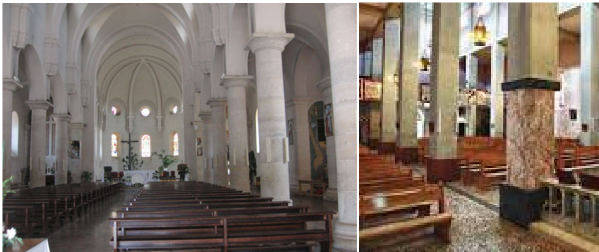
Slike 24.-25. Okrugli stupovi od punog kamena u crkvi BDM u Širokom Brijegu (lijevo); Četvrtasti stupovi od punog kamena u crkvi Uznesenja BDM na Šćitu, dio kojih je obložen mramorom (desno)
