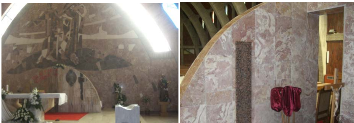
Slike 36.-37. Iznimno lijep mozaik izrađen iza glavnog oltara crkve u Kočerinu. Korištene su 3 vrste kamena: sivi vapnenac, roza breča i tamna breča su od autohtonih vrsta kamena (lijevo); Zid između oltara i ulaznih vrata u crkvu. Zid je posebna cjelina i nije povezan sa drugim zidovima. Kompletно je obložen „rozim mramorom“ (desno)
