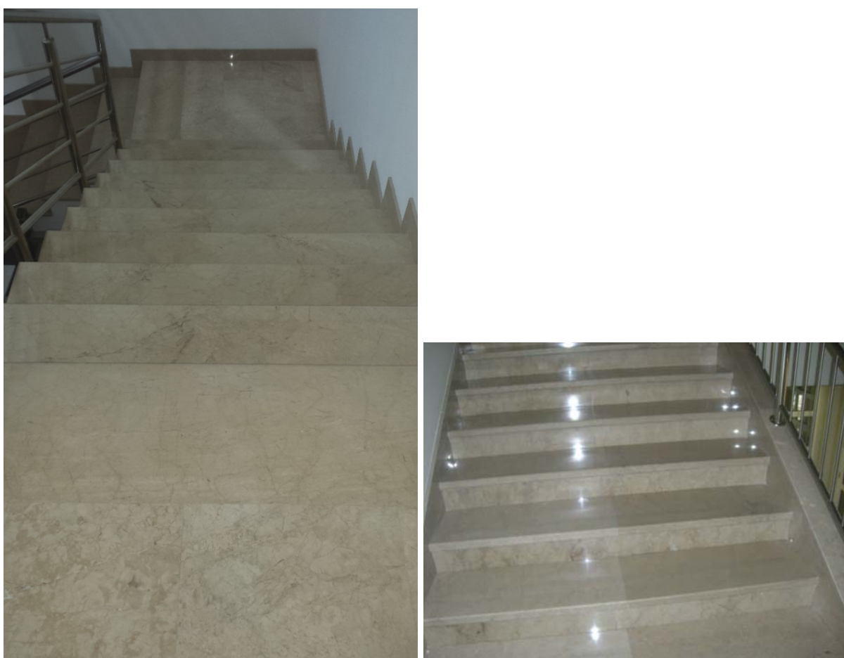
Slike 17.-18. Stubište sa podestima u poslovnoj zgradi „IGH“ Mostar (lijevo) i stubište u zgradi Općine Posušje (desno); Autohtoni kamen tipa „Osoje“, polirano
