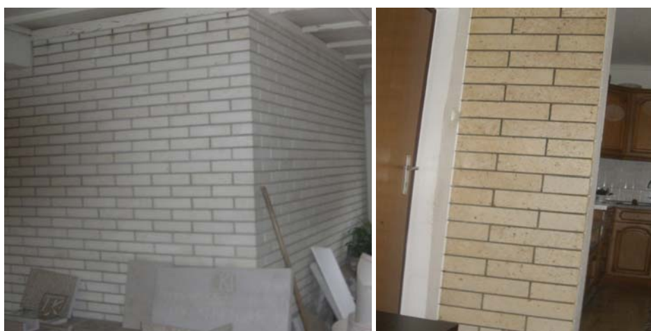
Slike 30.-31. Oblaganje pregradnog zida u poslovnom prostoru kamenim pločama malih dimenzija. Kamen je izrazito bijele boje autohtonog porijekla sa lokaliteta Bosiljna kod Rakitna. Vrsta se dosta koristi u kombinaciji sa drugim vrstama (lijevo); Ista vrsta kamena kao na prethodnoj slici. Obložen je jedan detalj u stambenom objektu (desno)
