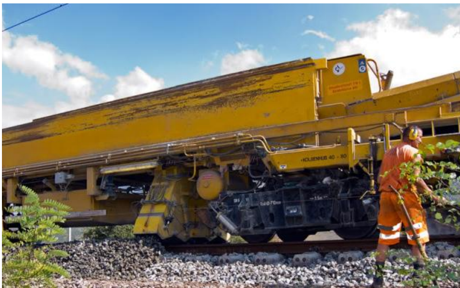
Slika 9. Ugradnja novog tucanika
