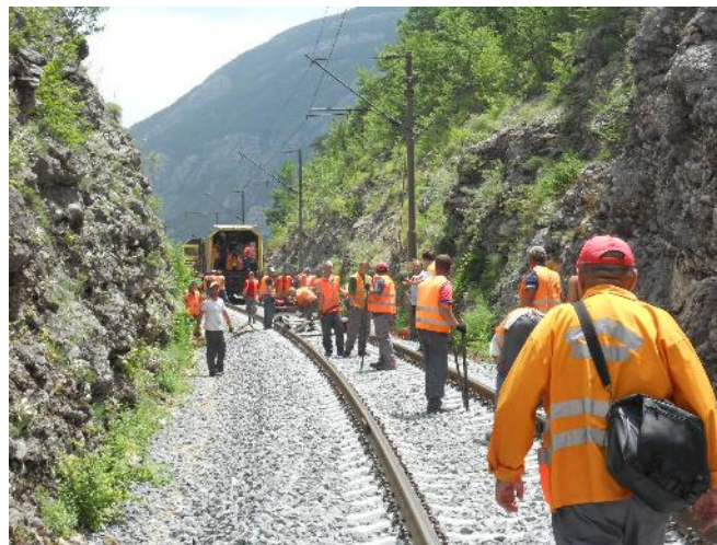
Slika 18. Oslobađanje tračnice od naprezanja
