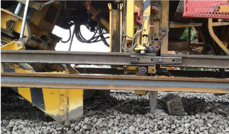
Slika 10. Jedinica za uklanjanje starih pragova
