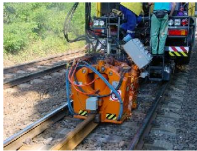
Slika 19. Elektrootporno zavarivanje na gradilištu
