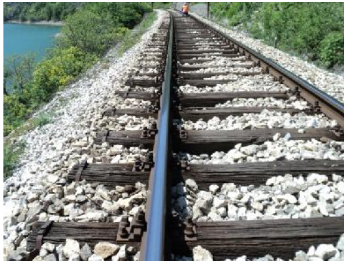
Slika 1. Kolosijek prije rekonstrukcije
