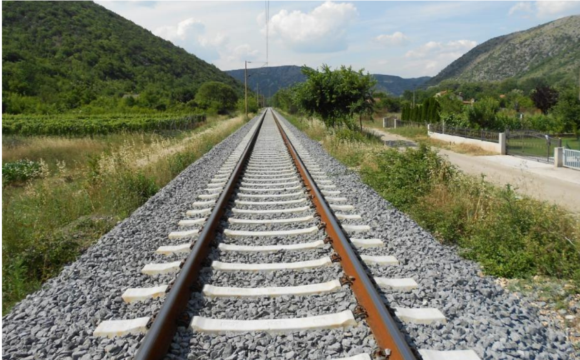
Slika 22. Željeznička pruga poslije rekonstrukcije
