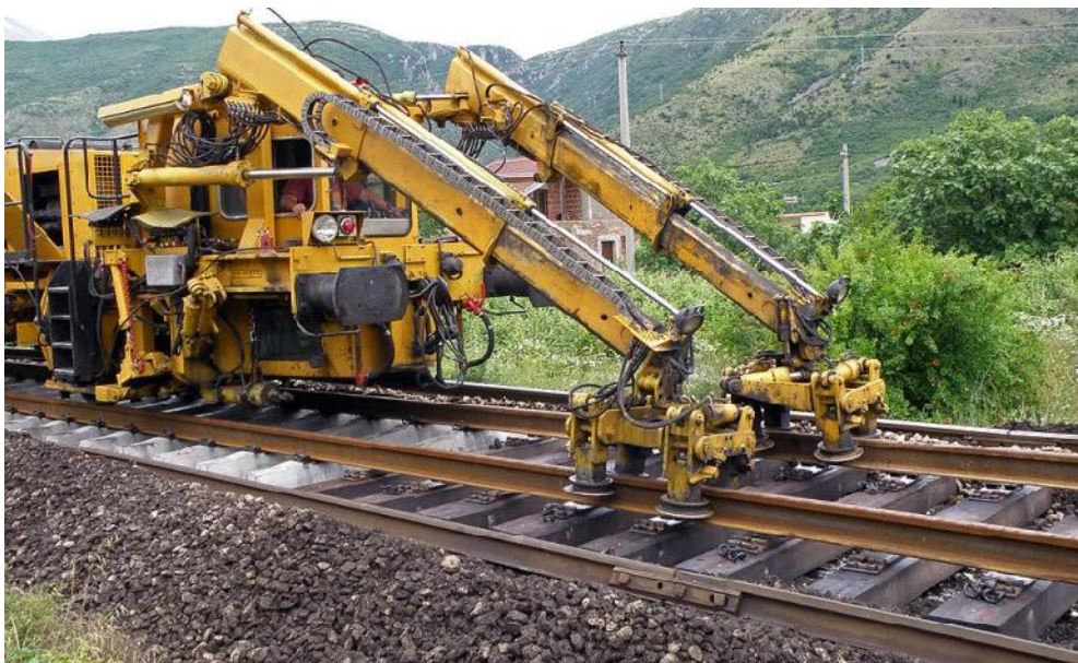
Slika 13. Regulacija nove tračnice
