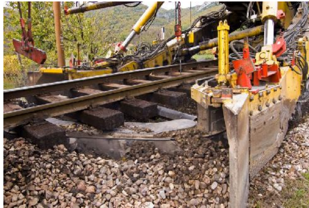
Slika 6. Strojni iskop starog tucanika
