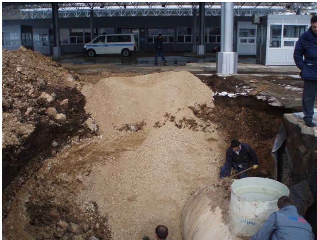
Slika 3. Ugradnja separatora ulja G. Prelaz Klobuk-Zupci
