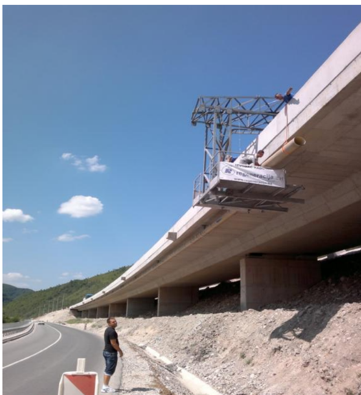
Slika 10. Odvodnja mostova
