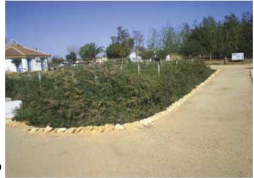
Slika 4.2. Opitni uređaj za tretman otpadnih voda malih naselja - „vještačka močvara“
