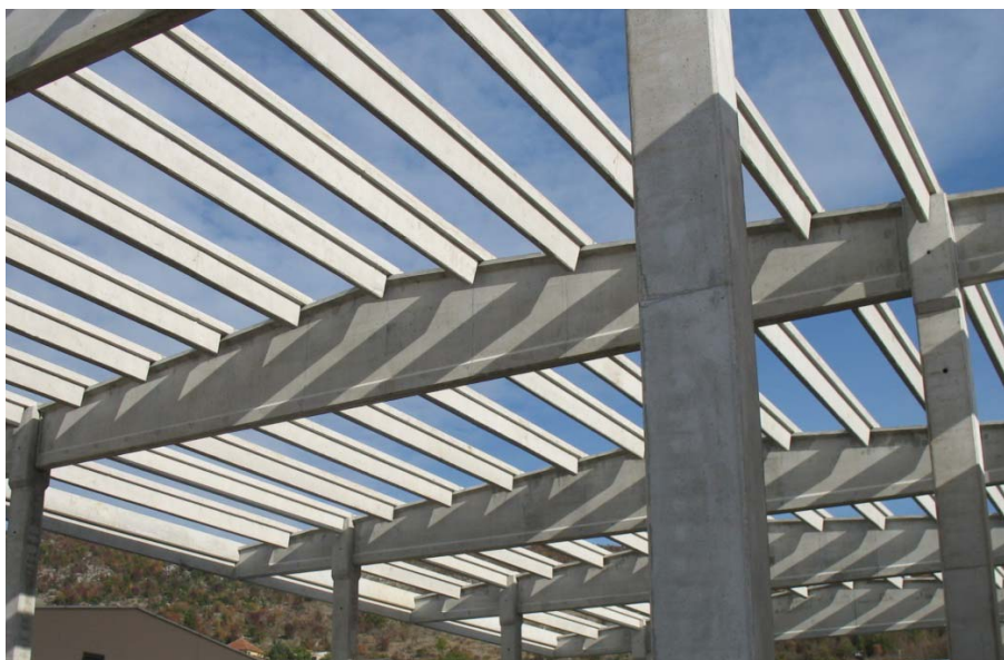
Slika 1. Primjer primjene T nosača u konstrukcijama hala
