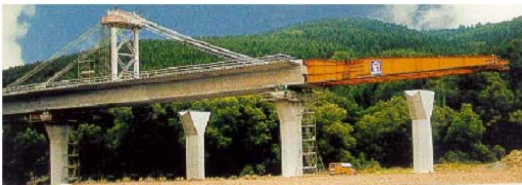
Slika 16. Pilon za ojačanje rasponske konstrukcije
