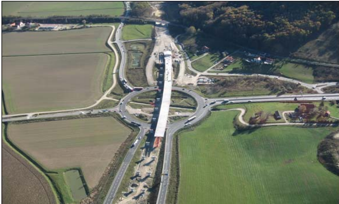
Slika 1. Viadukt Rondo tijekom izgradnje
