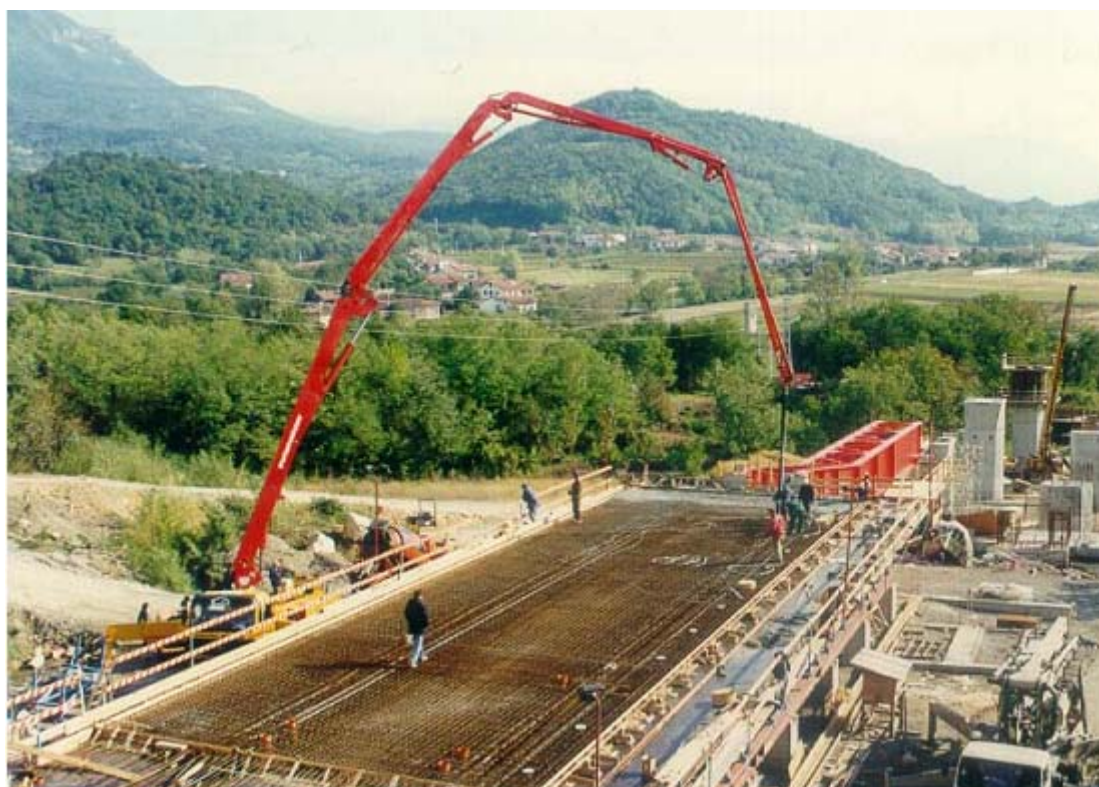
Slika 3. Platforma za izradu rasponske konstrukcije
