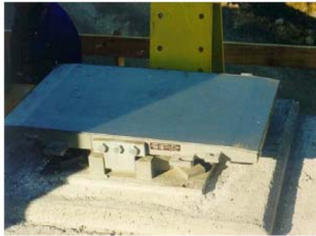
Slika 20. Shema konačnog i privremenog ležišta
