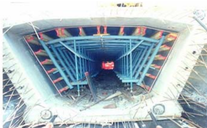
Slika 5. Poprečni presjek rasponske konstrukcije u oplati
