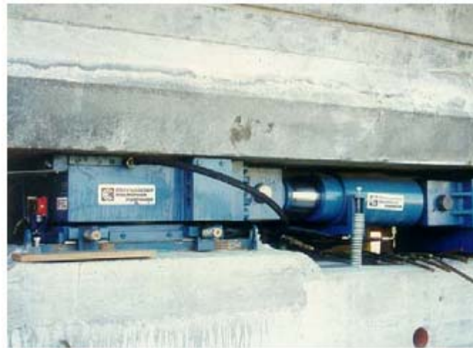
Slika 12. Hidraulička oprema za postupno potiskivanje
