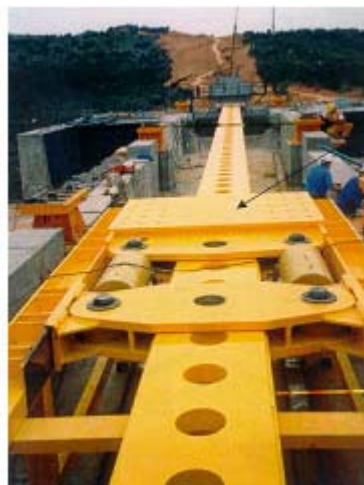
Slika 13. Hidraulička oprema za postupno potiskivanje gdje se horizontalna sila uvodi samo preko vlastite težine ošupljenim čeličnim nosačem rasponske konstrukcije koji je sinkrono vezan na hidrauličku opremu.
