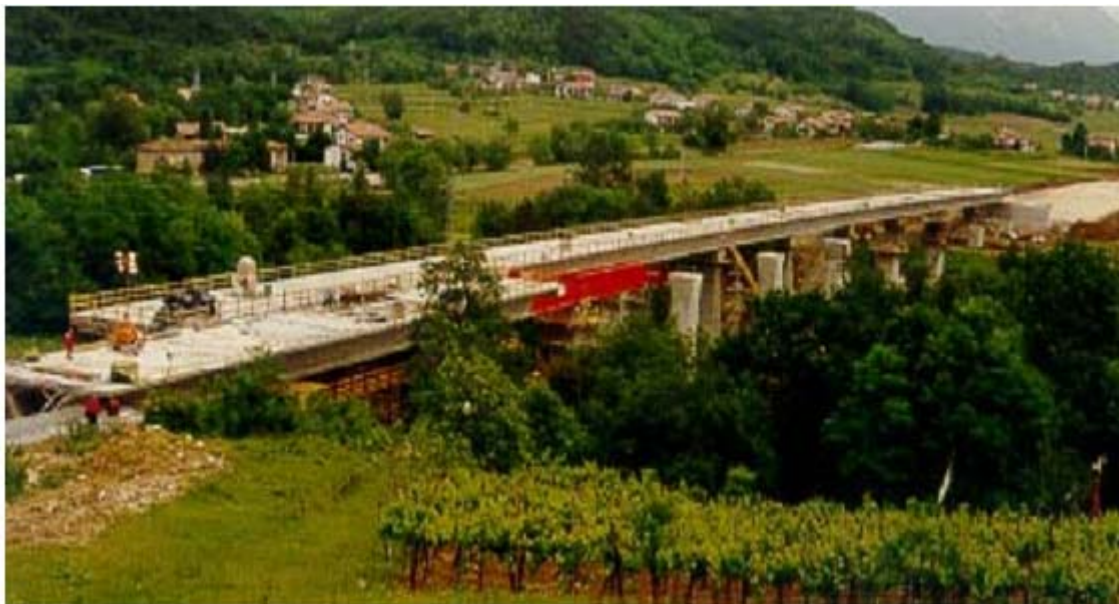
Slika 2. Konačni izgled vijadukta SELO izgrađenog po tehnologiji postupnog potiskivanja
