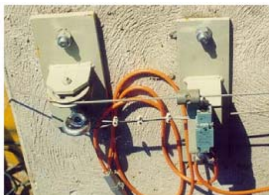
Slika 25. Senzori glavne rasponske konstrukcije
