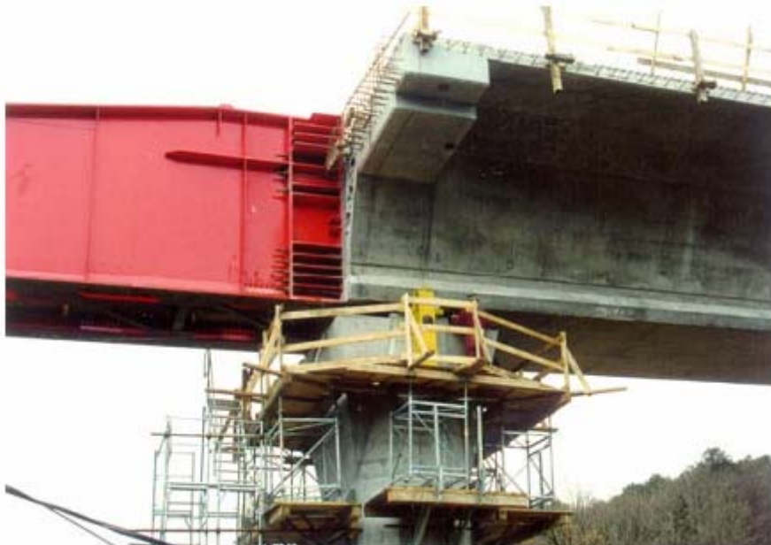
Slika 15. Pritvrđivanje kljuna na rasponsku konstrukciju i radna oplata na stupu
