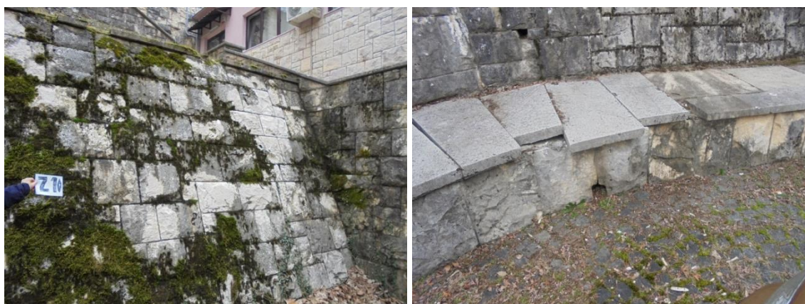
Slika 2. Pojava vegetacije i mehaničko oštećenje klupica
