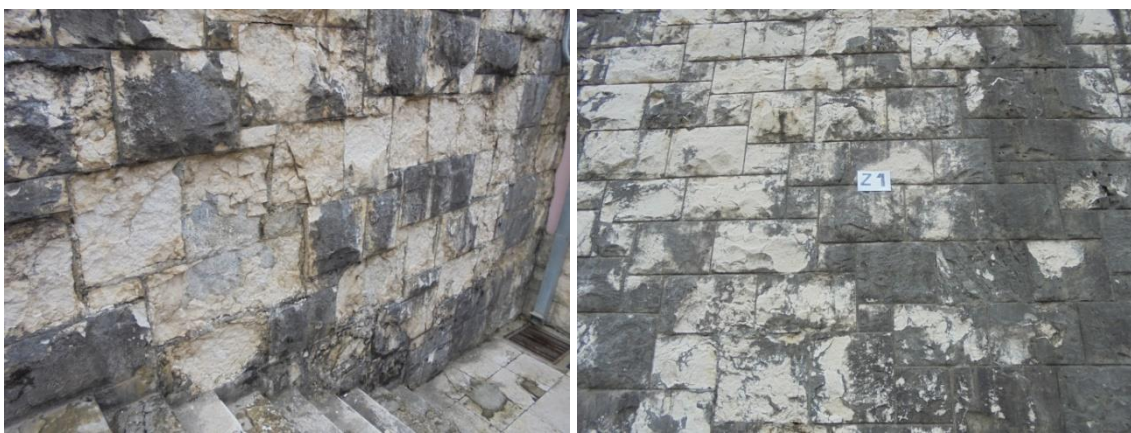
Slika 1. Odlamanje dijelova kamene obloge i pojava bijelih mrlja
