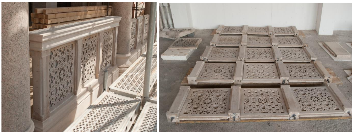
Slike 3.-4: Poslije čišćenja i zamjene pojedinih dijelova ograde balkona i lođe (foto: HM-Tenax)
