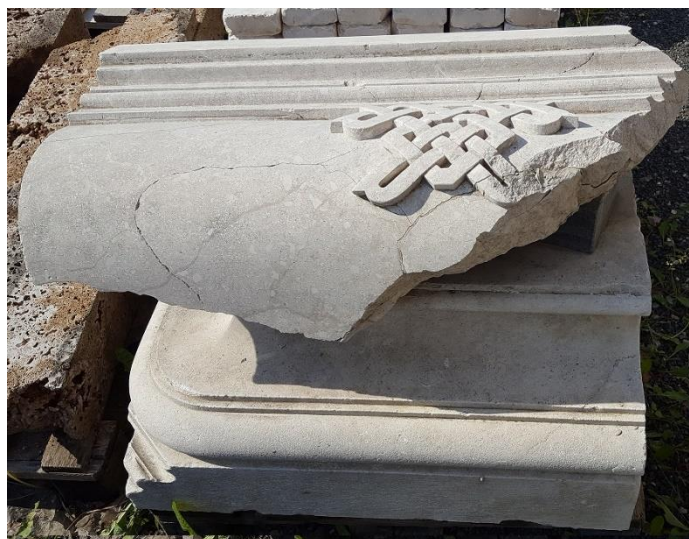
Slika 1: Destrukcija kamena postojeće česme u vidu prslina i fragmentiranja kamena (foto: Azra Kurtović)
