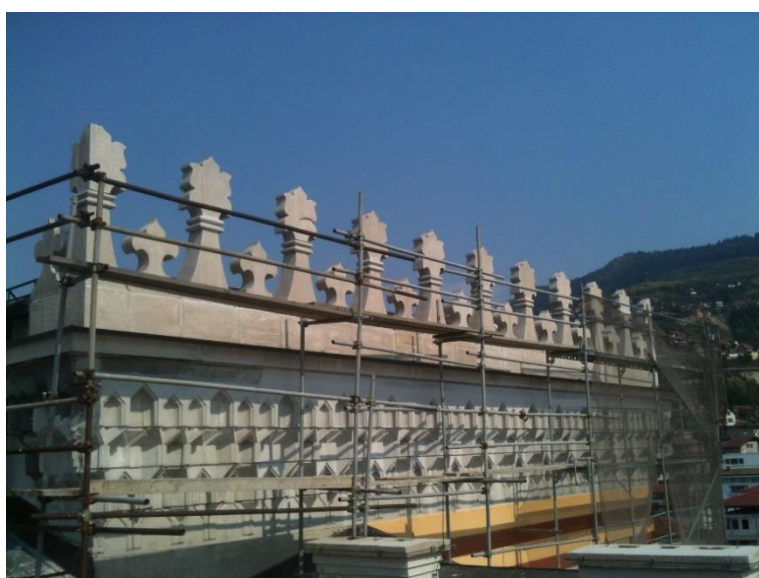
Slika 8: Izgled krovnog vijenca nakon čišćenja i zamjene kamenih elemenata. Raskošni friz stalaktita krovnog vijenca i kamenih cvjetova (barbakani) (foto: HM-Tenax)
