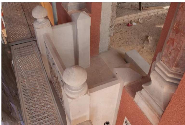
Slika 5: Element ograde poslije čišćenja i zamjene kamenih dijelova (foto: HM-Tenax)
