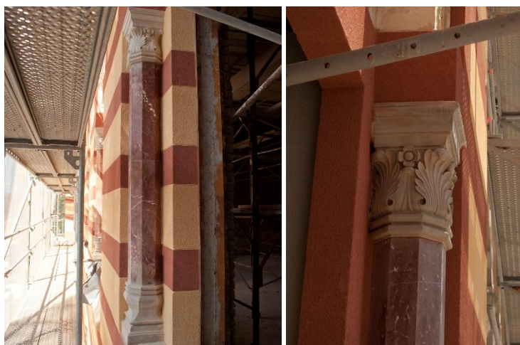
Slike 14.-15: Izgled tijela i nadkapitela stuba nakon rekonstrukcije i postavljanja završnog fasadnog maltera u boji, u nizovima žutih i crvenih traka (imitacija redova kamena) (foto: HM-Tenax)
