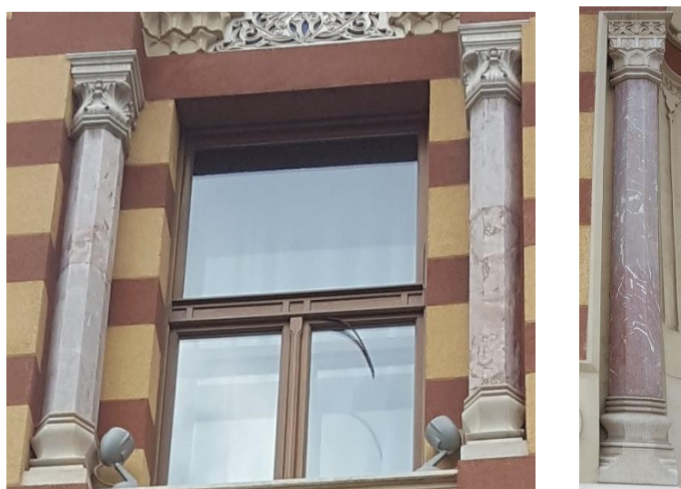
Slike 17.-18: Zamjenski kamen crvena breča; II. etaža južno pročelje fasade (lijevo); Uz vanjsku česma na trijemu, glavni ulaz južno pročelje fasade (desno) (foto: Azra Kurtović)
