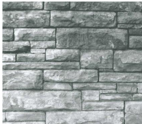
Slika 6. Primjer zida od obrađenog/tesanog kamena sa nepravilnim redovima klase N3 (DIN EN 1996-1-1, slika NA.L.6)
