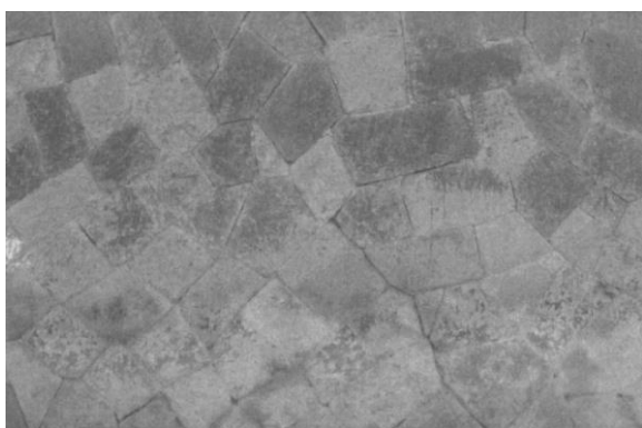
Slika 3. Primjer kiklopskog zida (DIN EN 1996-1-1, slika NA.L.3)
